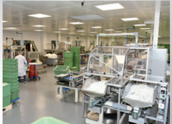
Blick in einen Teilbereich der neu erstellten Reinraumfertigung für medizintechnische Produkte View of a partial area of recently installed cleanroom production for medico-technical products
