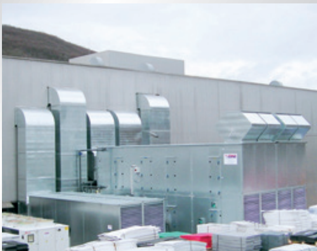
Außenansicht einer Lüftungszentrale Exterior view of a ventilation center
