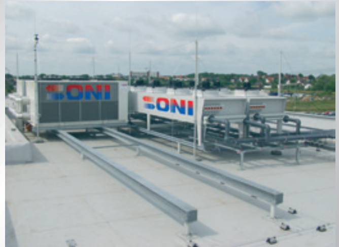
Zweikreis-Kühlanlagentechnik mit Winterentlastung zur Stromersparung an Kältemaschinen bis zu 80 % Double-circuit cooling system technology with winter relief for saving current up to 80 % on chillers
